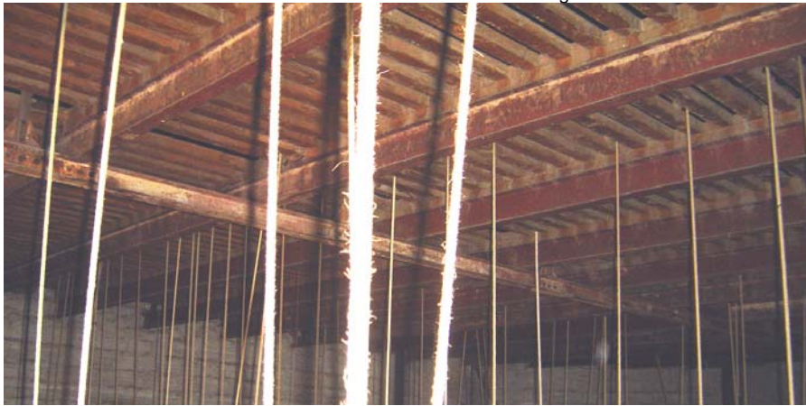
Vista del peine de madera y cuerdas para suspensión de barras de decorados e iluminación escénica
